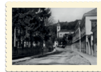
Heutiges Haus C von der Mackgasse aus gesehen gen Kalksburger Kirche. Am rechten Bildrand ist ein kleines Häuschen zu erkennen. An gleicher Stelle steht heute das Haus B.
